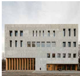
Marga Klompé-Gebäude Tilburg | Niederlanden
