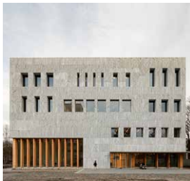
Marga Klompé-Gebäude Tilburg | Niederlanden
