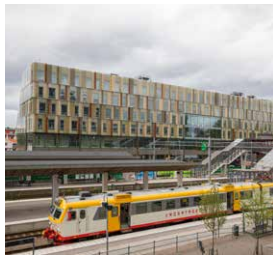
Estación de ferrocarril y ayuntamiento 'Stadshus', Växjö | Suecia
