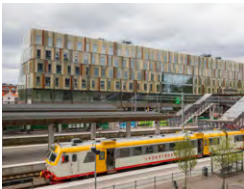
Estación de ferrocarril y ayuntamiento 'Stadshus', Växjö | Suecia
