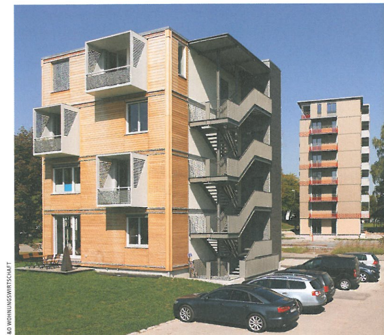
▲ Mit dem Viergeschosser „Holz 4“ (vorn) ging es auf dem Kasernenareal im Jahr 2010 los. Seit 2011 steht gleich nebenan der Achtgeschosser „Holz 8“
