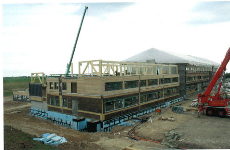
Die Außenwandelemente wurden komplett im Werk vorproduziert und dann bauseits zusammengesetzt.
