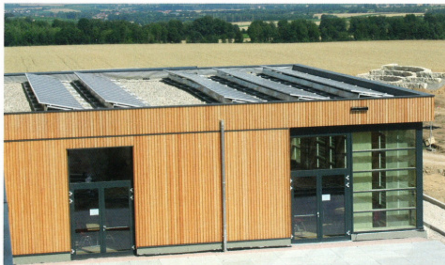
Fotovoltaikanlagen auf dem Dach und an der Fassade erzeugen den Solarstrom.
