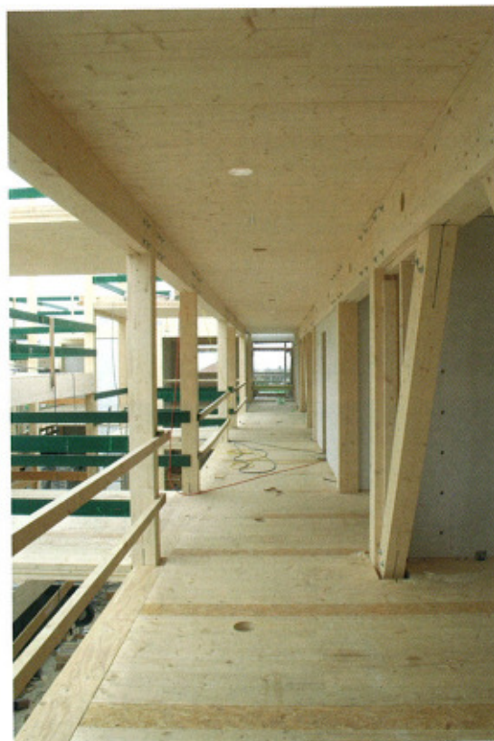
Die Holzbauer errichten den Holzskellettbau und stellen die vorgefertigten Wandelemente auf.
