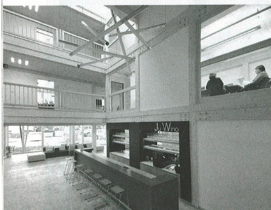
1000 m 3 Binder-Brettsperrholz wurden verbaut
