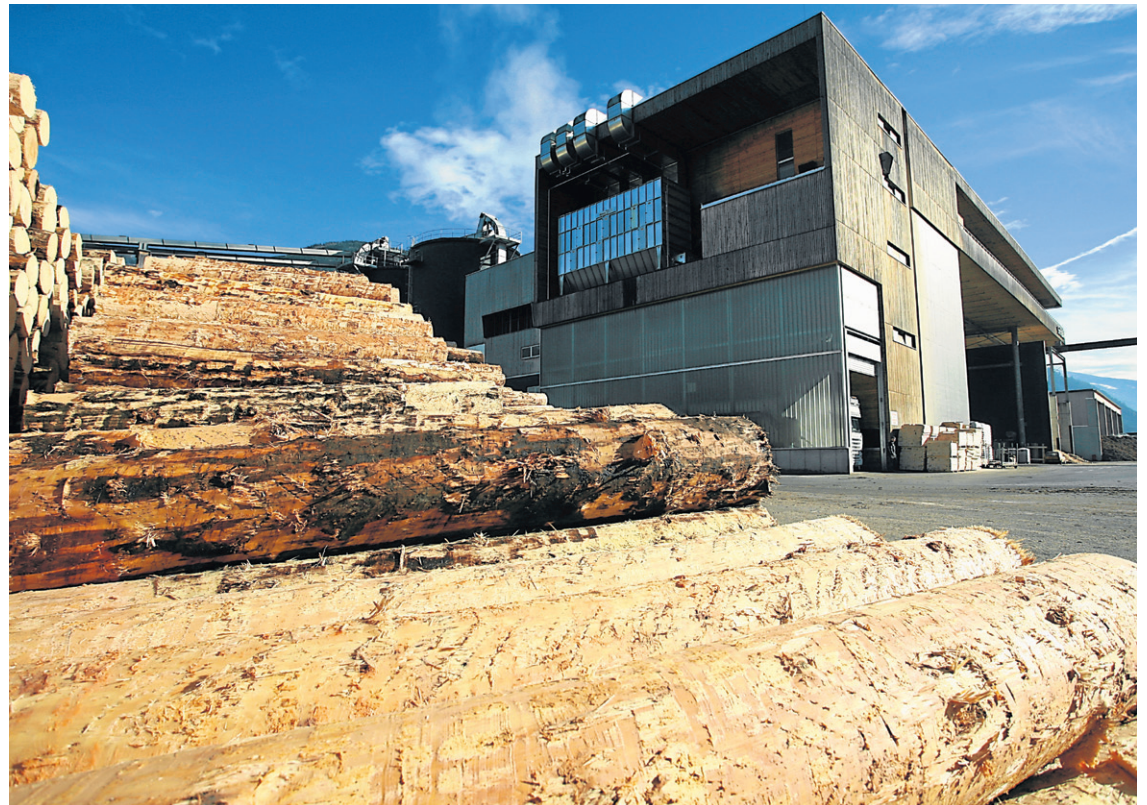
Nachhaltiges Bauen ist international im Kommen, der Trend geht daher weg von Beton, hin zu Holz. Davon profitiert das Tiroler Unternehmen Binderholz
