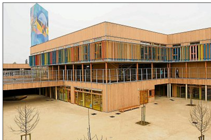
Drei Kindergärten und zwei Grundschulen umfasst das neue Schulzentrum.
