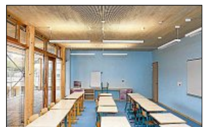
Eine der Vorgaben war eine Konstruktion ganz aus Holz. Deshalb bestehen Wände, Decken und Fassaden aus Massivholz.
