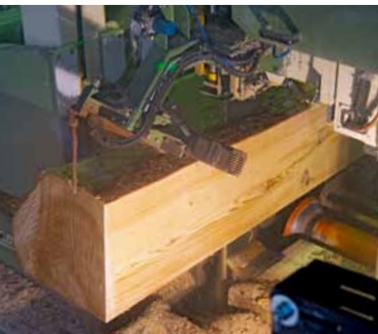
Das Vorritzaggregat befreit die Schnittfuge von der Rinde
